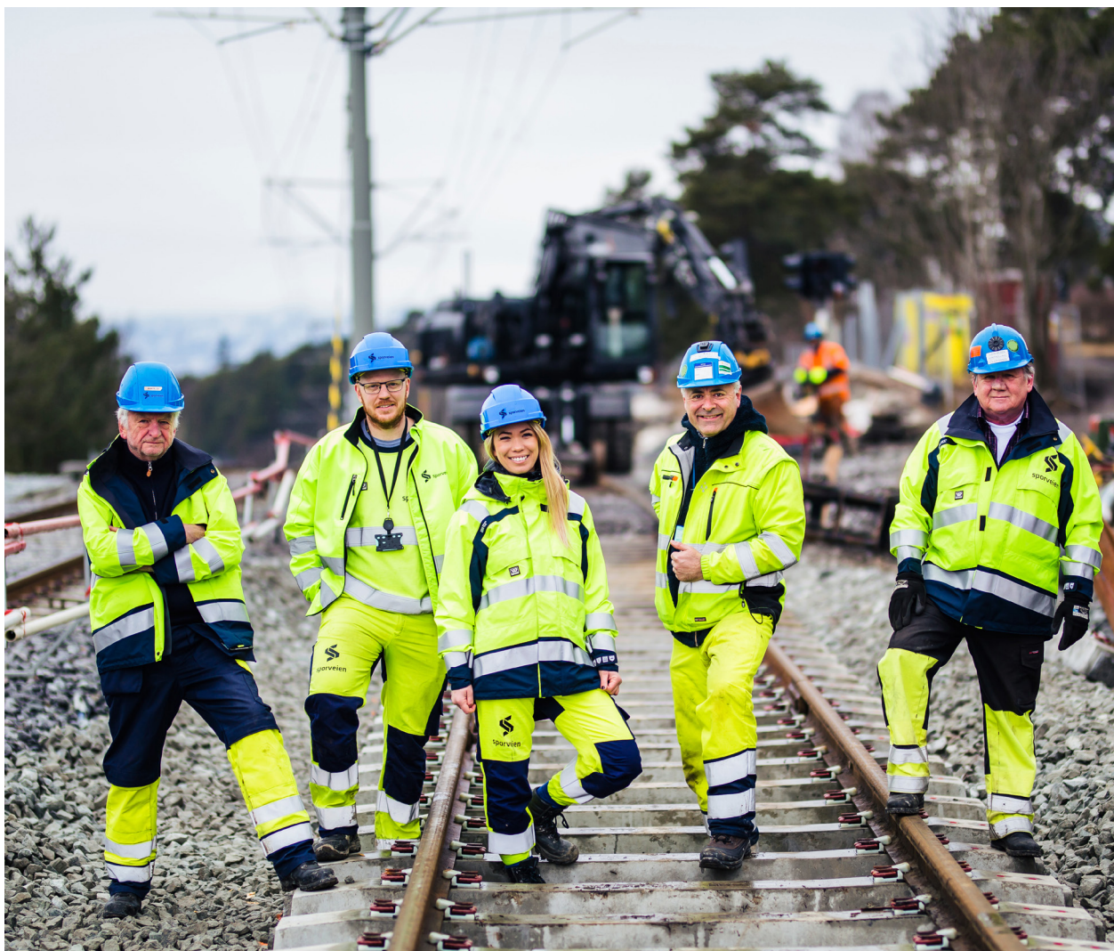
Ekebergbanen fyller 100 år i 2017 og er en viktig del av Oslos trikkehistorie. I jubileumsåret oppgraderes banen til å ta i mot nye trikker, og dermed også bli en del av fremtidens byreise i årene som kommer. Sporveiens enhet for Infrastruktur og prosjekter har ansvaret for oppgraderingen. Fra venstre: prosjektleder Arild Bratlie, kontrollingeniør Eirik Frøysa, byggeleder Kamilla Malt Marøy, kontrollingeniør Arne Åsheim og kontrollingeniør Svein Nilsen. Tegningen over er hentet fra Sporveiens jubileumshefte «Sporveien i Oslo 1875-2015 – 140 år på skinner», av Kristian Krohg-Sørensen.
